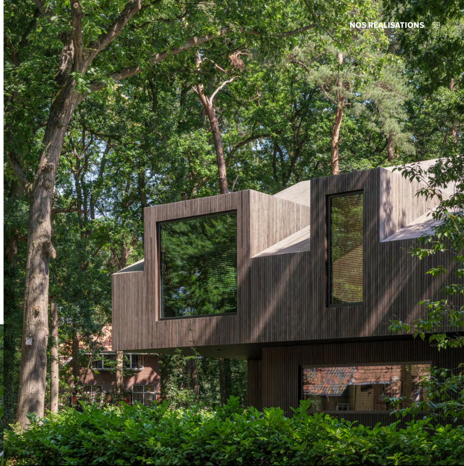
↑ De l'extérieur, SPEEHUIS arbore une façade attrayante composée de poutres en Bamboo X-treme®, qui se clipsent sur le système Grad. Les clients ont fait appel au système Grad® pour sa rapidité d'installation et facilité de démontage.
